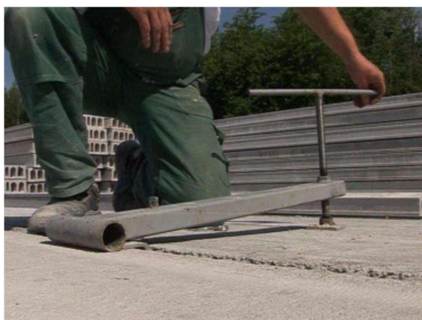
Rys.4 Wyrównanie dolnych powierzchni płyt za pomocą rekomendowanego urządzenia
